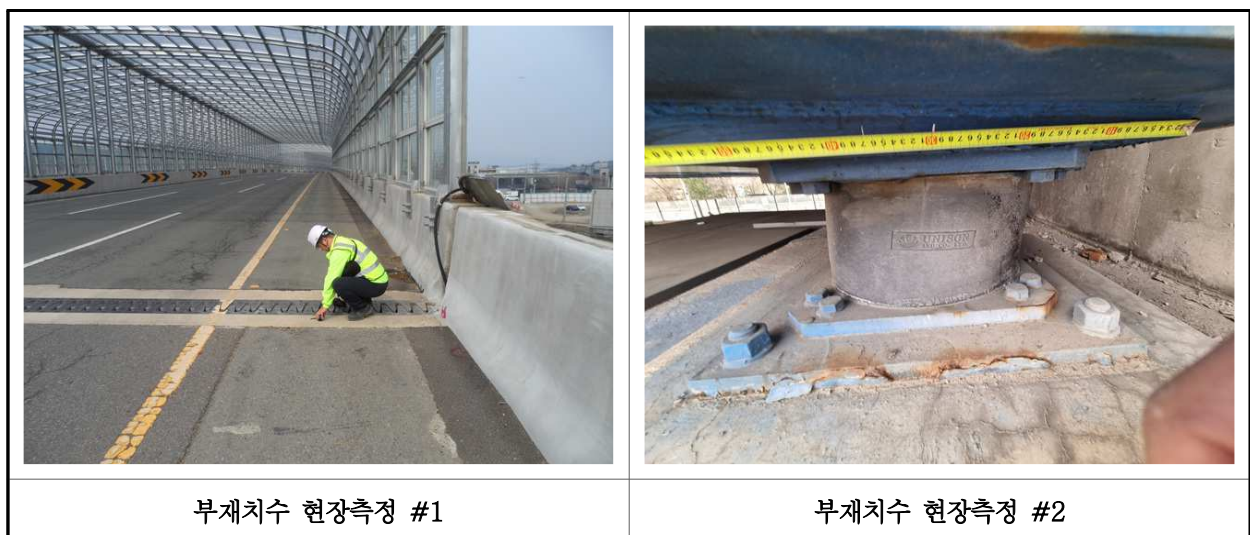
【사진 3.2.1】 부재 현장측정 전경
