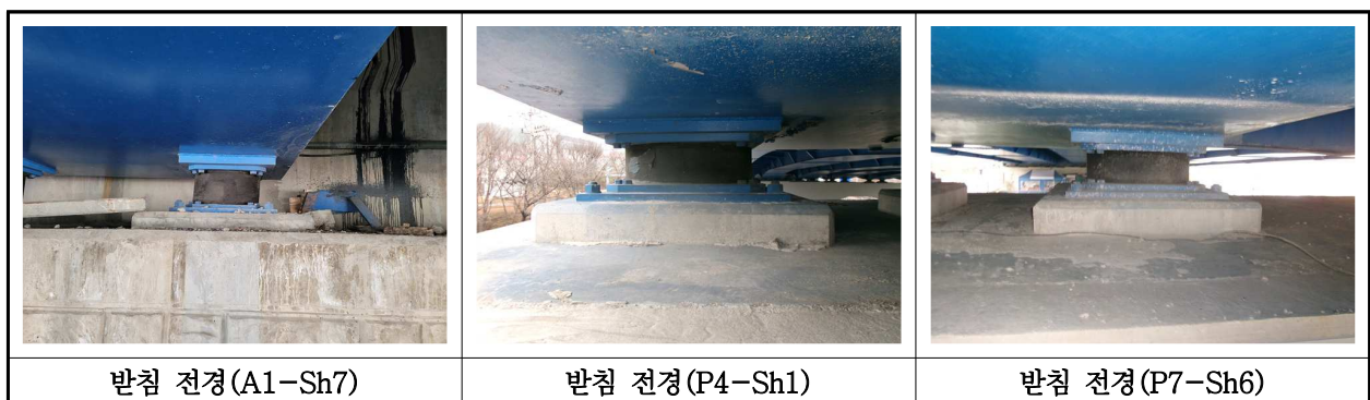
【사진 3.3.13】 교량받침 전경
