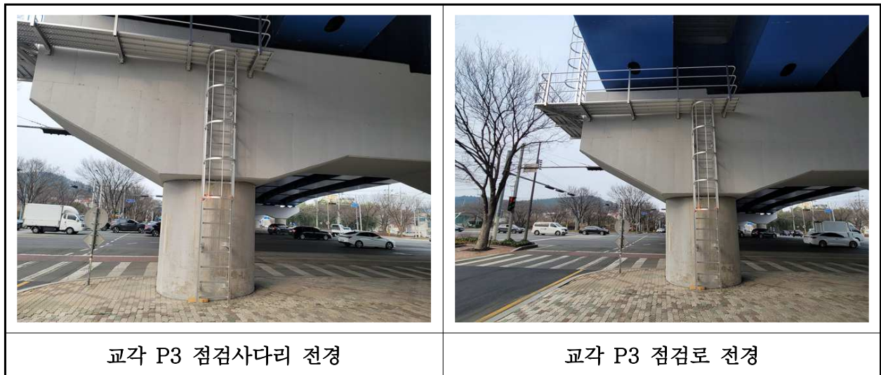
【사진 3.3.26】 교량 점검시설 전경
