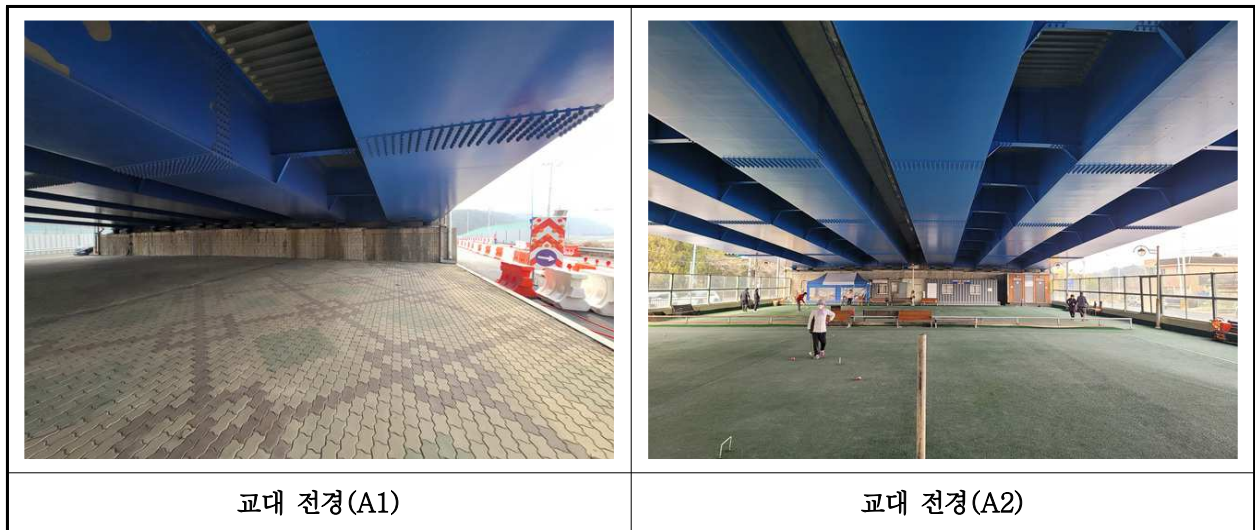
【사진 3.3.8】 교대 전경
