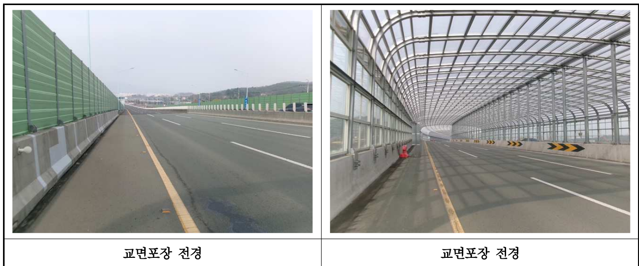
【사진 3.3.20】 교면포장 전경
