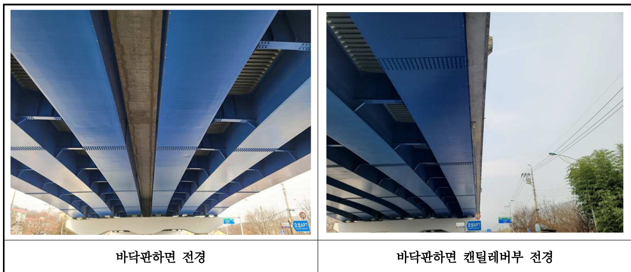
【사진 3.3.2】 바닥판하면 전경
