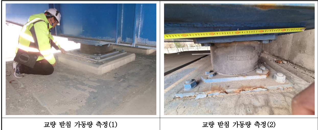
【사진 3.3.16】 교량받침 이동량 측정
